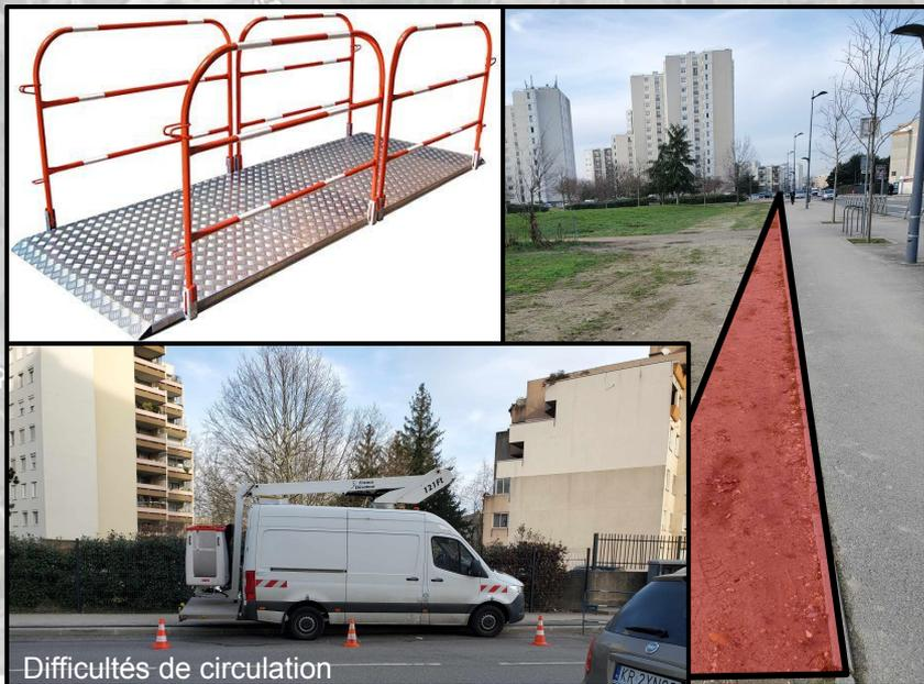
Pour permettre une circulation piétonne facilitée le long de la rue, mise en place d'un chemin sur le côté du trottoir pendant la phase travaux.
