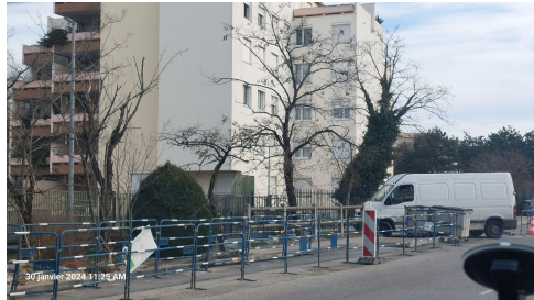
Photo de travaux de l'avenue Georges Dimitrov
