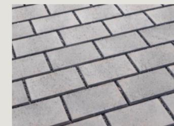
**Pavé perméable en béton :**
